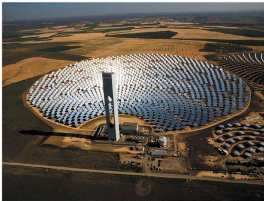
Figura 2.6 - Foto de usina heliotérmica com torre solar configuração 1.
