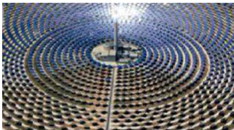
Figura 2.7 - Foto de usina heliotérmica com torre solar configuração 2.
